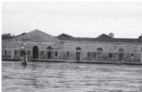
Macello di S. Giobbe; fronte verso la laguna visto dal ponte della ferrovia.
