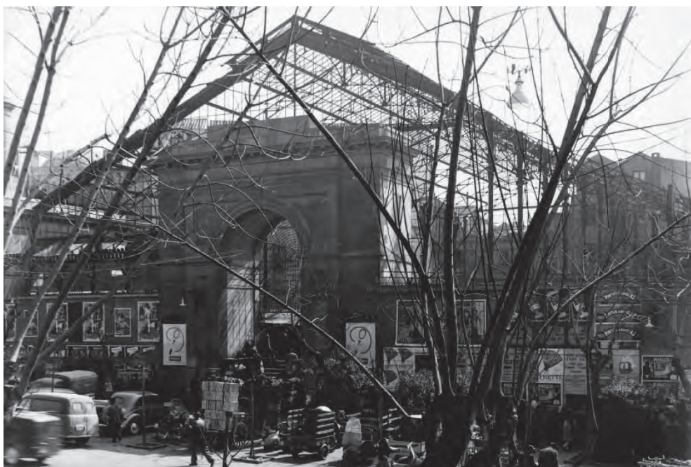
Fig. 1 - Mercato Civico di Cagliari (primi Anni 50 del '900 – Archivio famiglia Pietro Leo), facciata dell'edificio principale, con copertura in vetro e struttura portante in ferro e ghisa.
