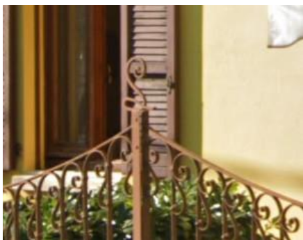
Fig. 89 – Particolare del cancello di Villa Laviosa a Campore con l'iniziale "L" del cognome Laviosa (Sitografia 5)
